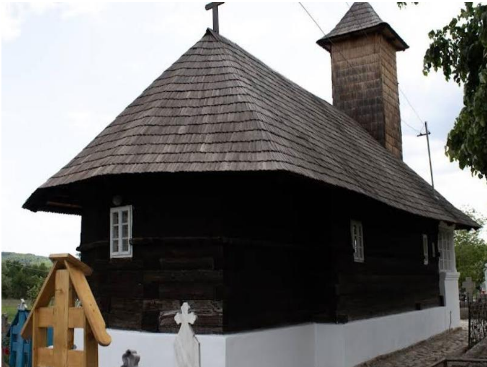
Foto 2: Fotografie BISERICA DE LEMN "SF. VOIEVOZI"
